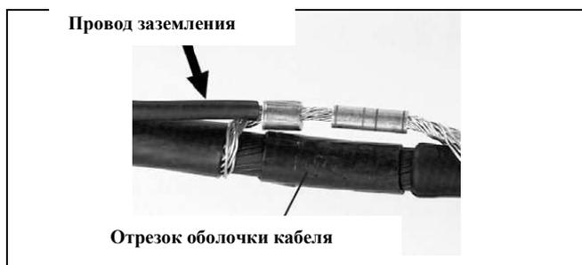
Соединение с проводом заземления не прижато к кабелю
