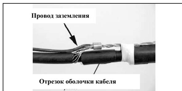
Соединение с проводом заземления прижато к кабелю
